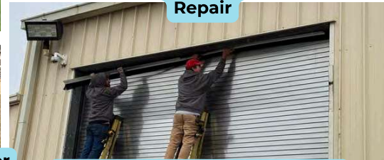
CC Landfill Garage Door Repairs
